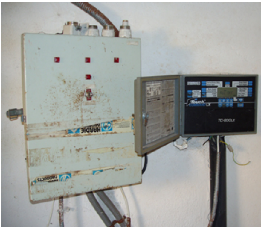
Εικ. 34 Εγκατάσταση προγραμματιστή άρδευσης σε γήπεδο ποδοσφαίρου
