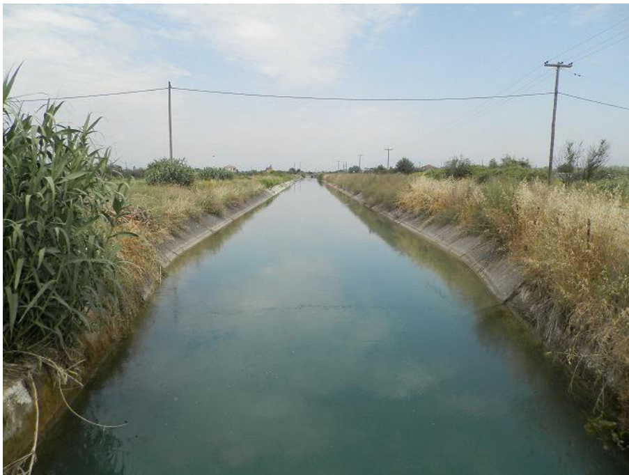
Εικ. 11 Τα γραφεία και ένα ενδεικτικό κανάλι του ΓΟΕΒ Αχελώου στο Αγρίνιο
